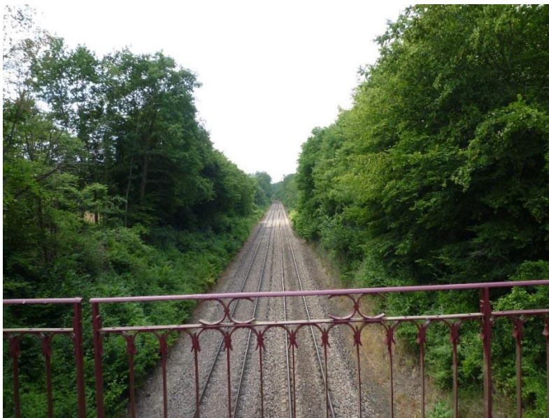
Ligne ferroviaire en fond de vallée
